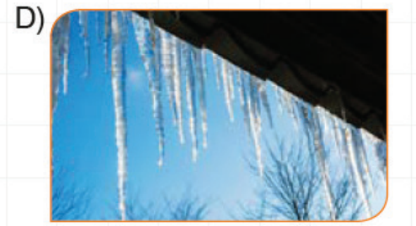
Çatılardan akan suların sarkıt hâlini alması
